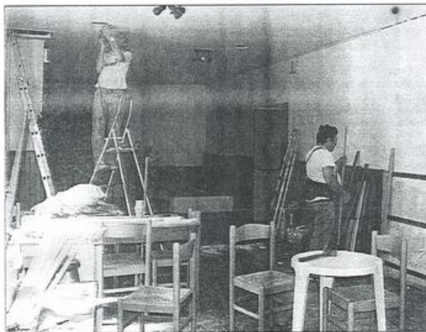
Le foyer est actuellement en chantier. - DDM
