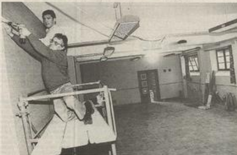
Les services techniques sont chargés de la rénovation.
