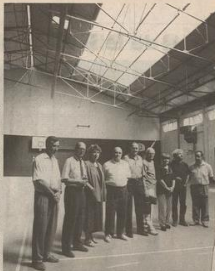
Visite de chantier pour la municipalité et la M.J.C.
