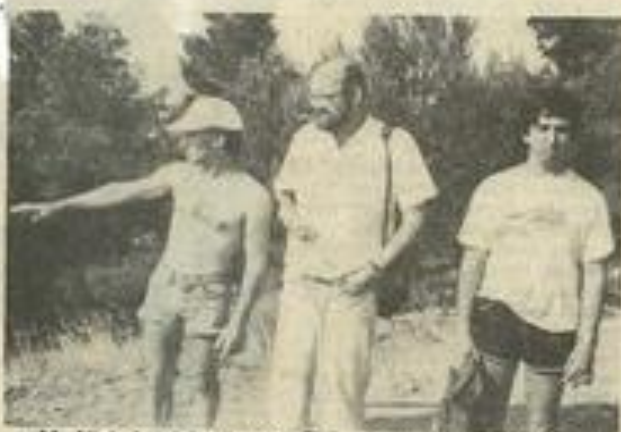
• M. Nickels visite le chantier, accompagné par Pierre Amoureux et Gérard Estienne.
