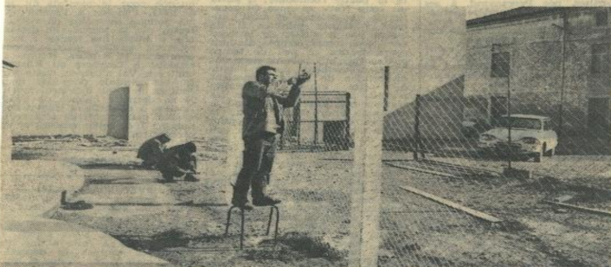
■ Le chantier que les services municipaux ouvraient en vue de la réfection du plancher qui menaçait de s'effondrer, s'est poursuivi et complété. Sur notre cliché une équipe des services techniques procède aux travaux d'aménagement du parking agrandi. Il est réservé en principe aux usagers et animateurs du 25 de la rue des Vosges.
