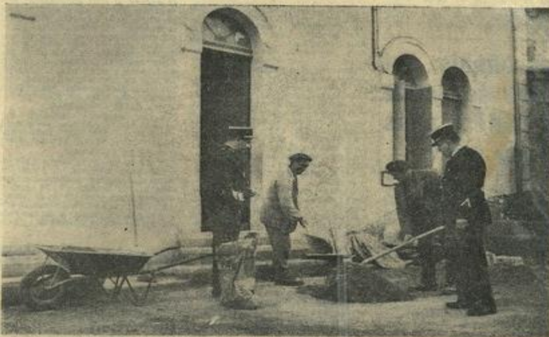
● Le chef Valez, de la brigade d'Espèzel, est venu se rendre compte de l'état des travaux d'aménagement du poste périodique de gendarmerie. (Photos A. Jover « L'Indépendant »)
