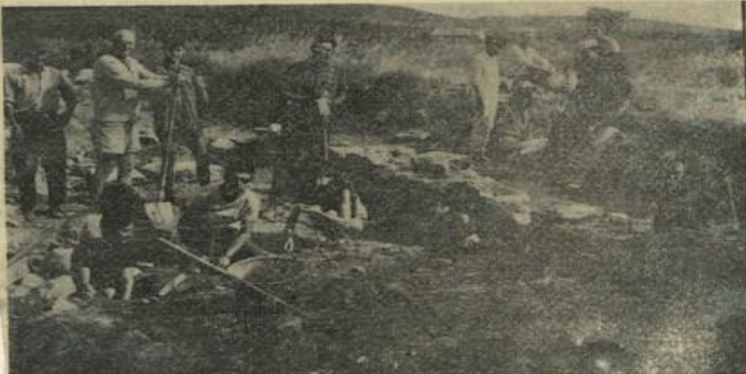
Une vue générale du chantier des fouilles.
