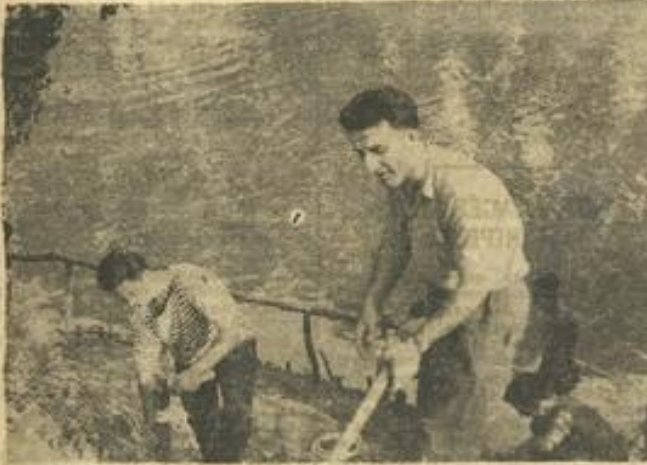
M. Teulon, directeur de la Maison des Jeunes, travaille à la construction d'un appontement pour les canoés, sur l'Aude. (Photo Costesèque)
